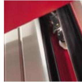
8. Il dispositivo paracadute inserito nelle guide agisce in caso di rottura delle funi bloccando la caduta della parte mobile.
